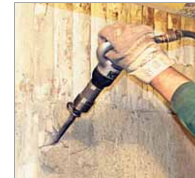
Abschlagen von Putz und Fliesen ohne viel Mühe
