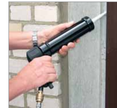
Spritzen – Fugen professionell und sauber verfüllen
