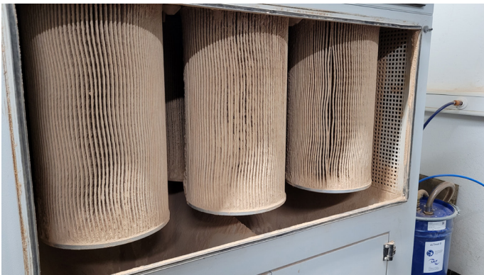
Blick auf die Absauganlage mit FG Staubfilterelementen Bildmaterial: SCHURTER GmbH
