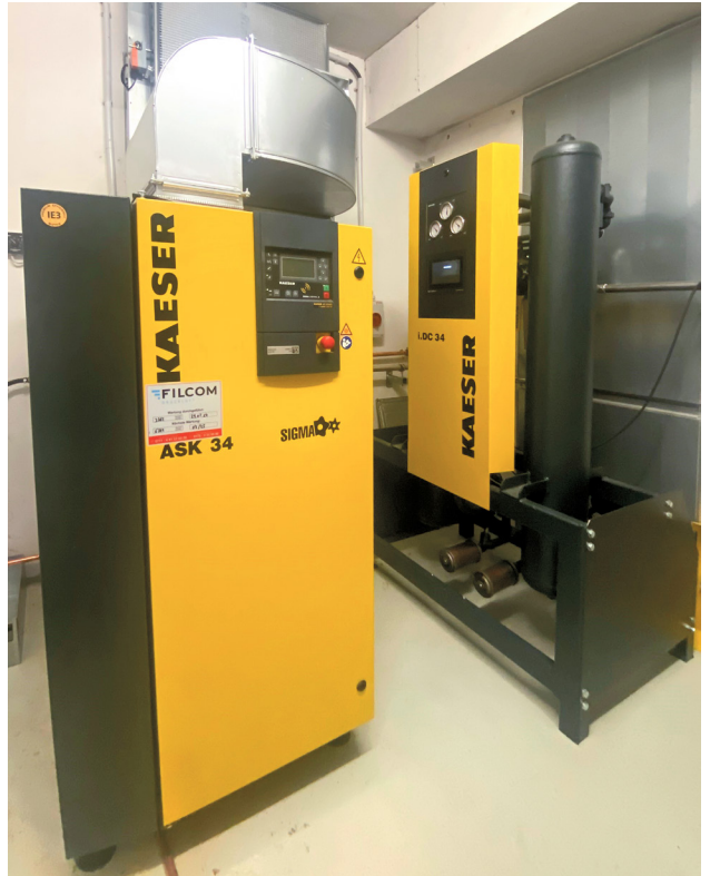
KAESER Schraubenkompressor und Adsorptionstrockner bei alphacam Bildquelle: alphacam GmbH
